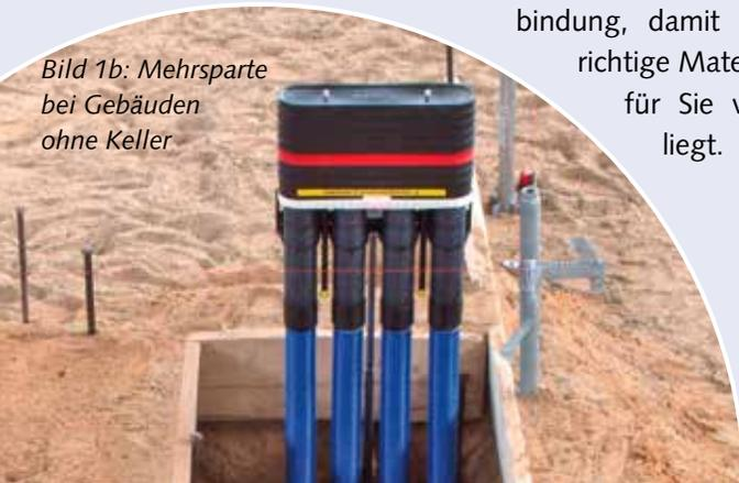
Bild 1b: Mehrsparte bei Gebäuden ohne Keller
